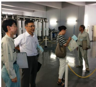
江山浄水場の膜ろ過施設の調査(岩永議員が撮影)
